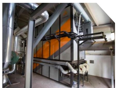
熱媒体油・蒸気・高温水によるバイオマスボイラ
